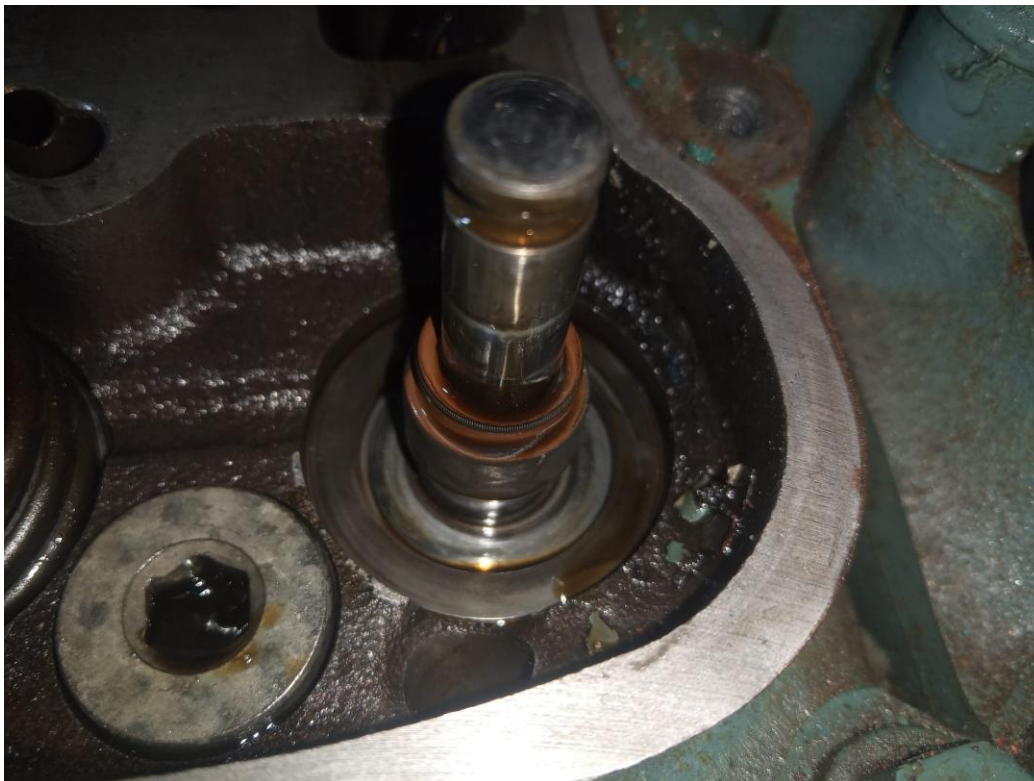
Bovenstaand een foto van de situatie als de klepveer is verwijderd, er is nu direct zicht op de klepsteel, klepgeleider en de te vervangen klepseal.
